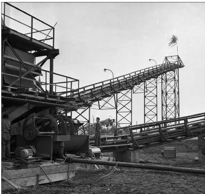
Oddelenie stavebníctva, dopravy a spojov sa venovalo aj výstavbe Východoslovenských železniární (Zdroj: Archív TASR)
